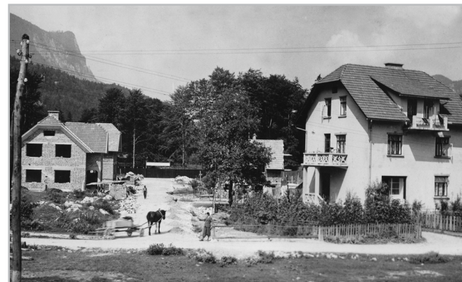
Gradnja hiš v Kurji vasi med Jeralovo in Ilirsko ulico leta 1938. Na desni je Sušnikova hiša. (last Cveta Jaklja)
