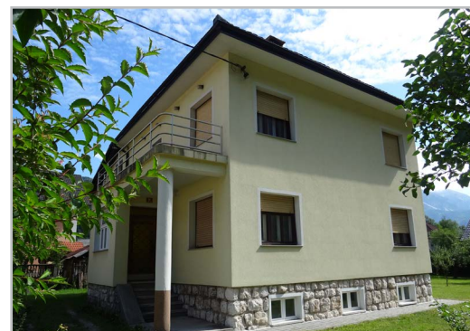
Prenovljena Čelesnikova hiša z velikim vrtom leta 2021 (foto Stane Arh)
