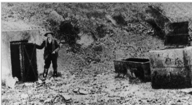
Gradnja vodnega zbiralnika nad Murovo (fototeka Gornjesavskega muzeja Jesenice)
