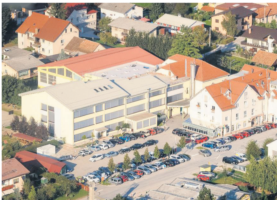
Prizidek so umestili med staro šolsko zgradbo in telovadnico. Foto: Občina Žalec
